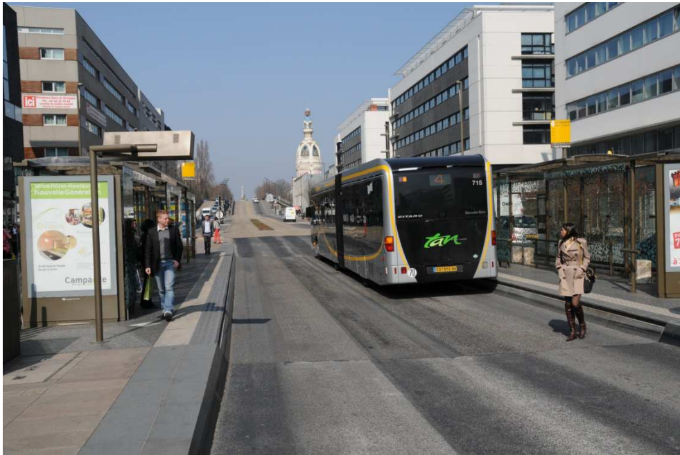
Figur 4-7 Buswayhållplats som möjliggör plant insteg genom nedsänkt körbana. Foto: PG Andersson
