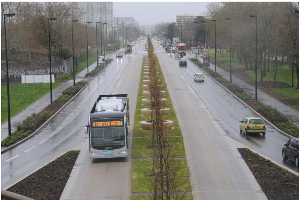
Figur 4-8 En stadsmotorväg som fick göra plats för Busway. Foto: PG Andersson
