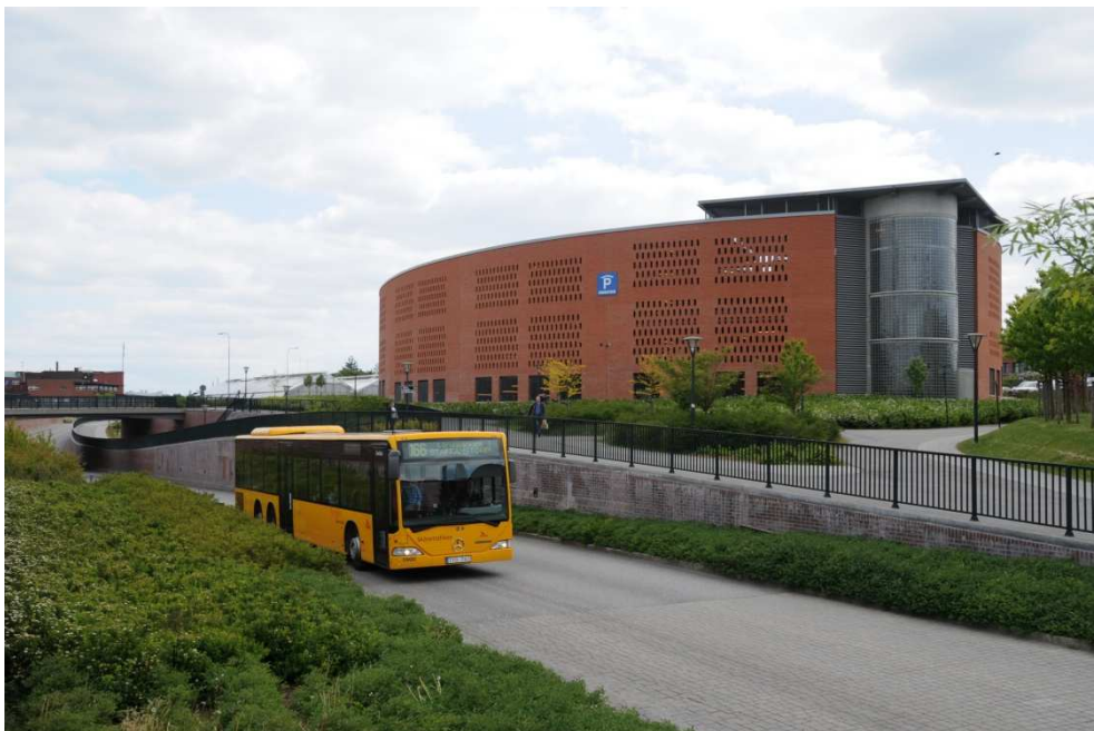
Figur 4-23 Lundalänken, en spårvägsförberedd bussbana. Foto: PG Andersson
